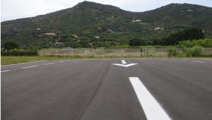
Particolare della recinzione in corrispondenza testata pista 16.
