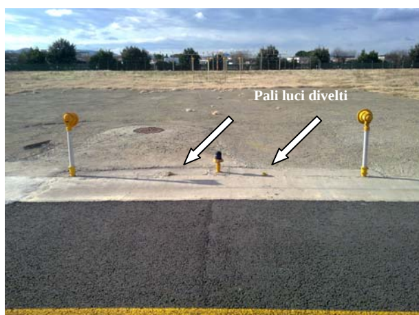
Aeroporto di Firenze Peretola: posizione pali divelti.
